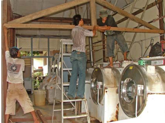
En la foto estamos trabajando con madera para poder proveer mayor cantidad de agua a las lavadoras.
